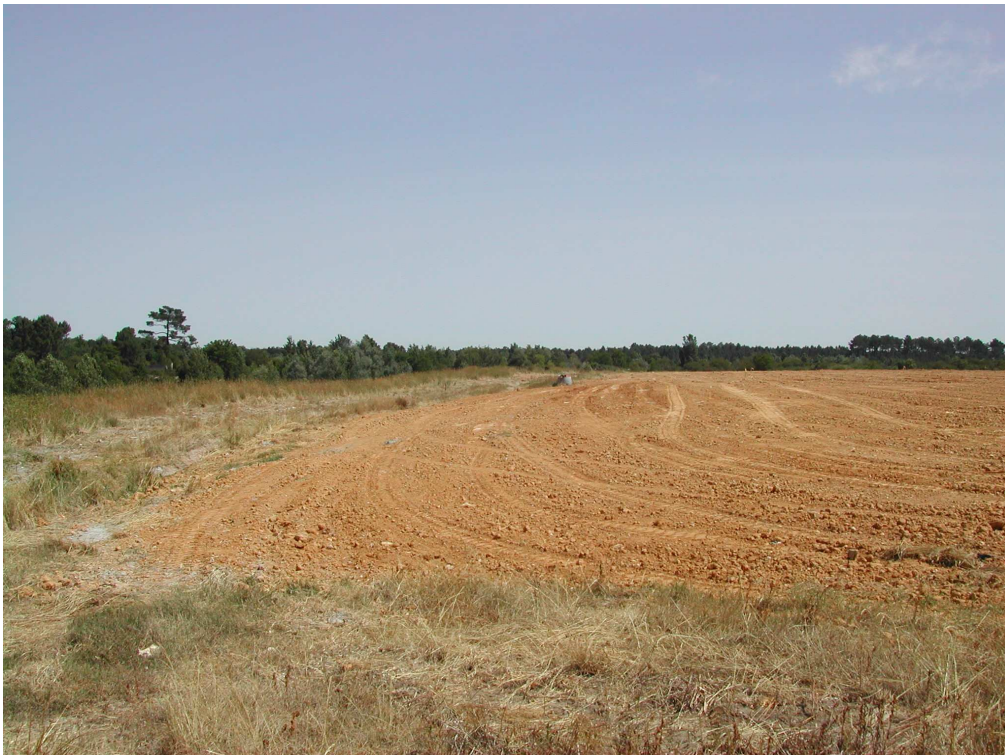
Photo n°2.2 : Apport de 15 000 m 3 de matériaux argileux en couverture
