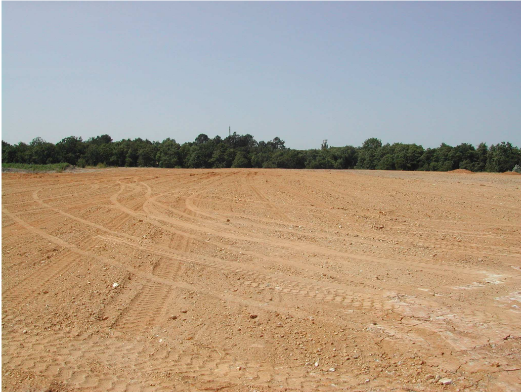
Photo n°2.1 : Apport de 15 000 m 3 de matériaux argileux en couverture
